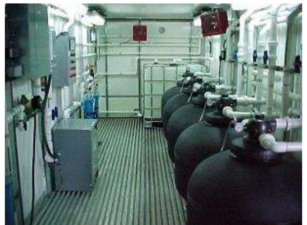
Unité de traitement mobile construite à l'intérieur d'un conteneur marin isolé
