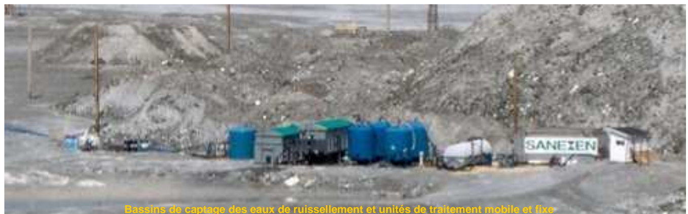
Bassins de captage des eaux de ruissellement et unités de traitement mobile et fixe
