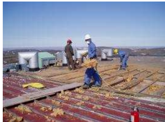
Déconstruction de bâtiments en prenant soin d'enlever les écailles de peinture à base de plomb et/ou de BPC et de matériaux isolants à base d'amiante.
